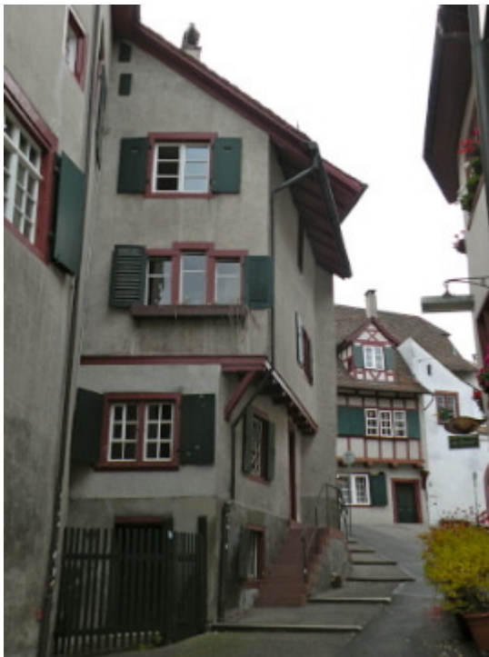
Dreifache Treppung (links i.d. Keller, rechts die Gasse bergan sowie zum Eingang hoch). Leonhardsberg 15, 4051 Basel
